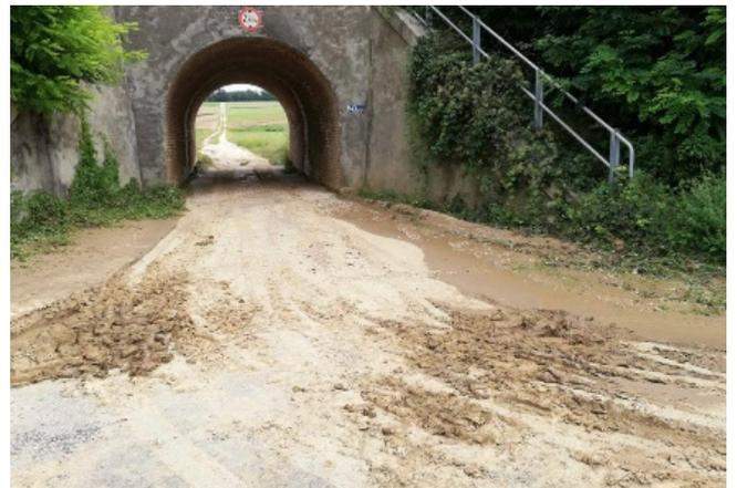
Im Bereich der Bahnunterführung des asphaltierten Verbindungsweges nach Neubau Kreuzstetten muss die Fahrbahn angehoben werden. Bei starken Regen kommt es hier immer zu erheblichen Schlammablagerungen. Bei diesen Wegen handelt es sich auch um ausgewiesene Radwege.
