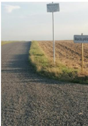
Der Weg von der L6 Richtung Kreuzstetterweg wurde fachgerecht saniert. Eine Spritzdecke (Bitumen und Rollsplit) wurde aufgebracht.
