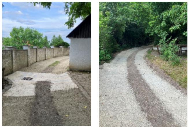
Weg wurde mit zementstabilisiertem Material wieder verfüllt, die Gefälle den Erfordernissen angepasst und Abläufe gesetzt bzw. saniert. Zwischen den Spurwegen wurde Erde verfüllt und Rasen angebaut. Somit ist auch dieser Bereich des Kellerweges auf Dauer saniert und dem Kellergassenbild entsprechend angelegt.
