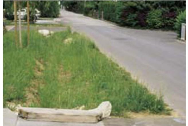
Der große Vorteil ist, dass auf teure Einlaufschächte und Kanalisationsleitungen verzichtet werden kann. Neuere innovative Möglichkeiten stellen Structural Soils und DrainGarden®-Systeme dar.
