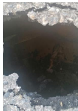
Nach Besichtigung wurde diese Stelle abgesichert, da sich unterhalb ein Hohlraum von ca. 1 Kubikmeter gebildet hatte. Von der Fa. Ha-Bau wurden die Kanäle fachgerecht eingebaut und wieder verschlossen.
