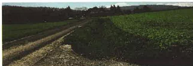
Neben dem Weg von der Badgasse Richtung Steinberg wurde der Ablaufgraben samt Rohrdurchlass wieder aktiviert. Bei der Einmündung des Güterweges wurde eine neu asphaltierte Einlaumulde angelegt. Aufgrund der nassen Böden wird der Auslaufgraben im nächsten Jahr den Erfordernissen entsprechend angepasst.
